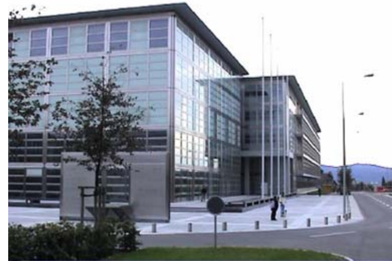
Chemiegebäude auf dem Höggerberg
